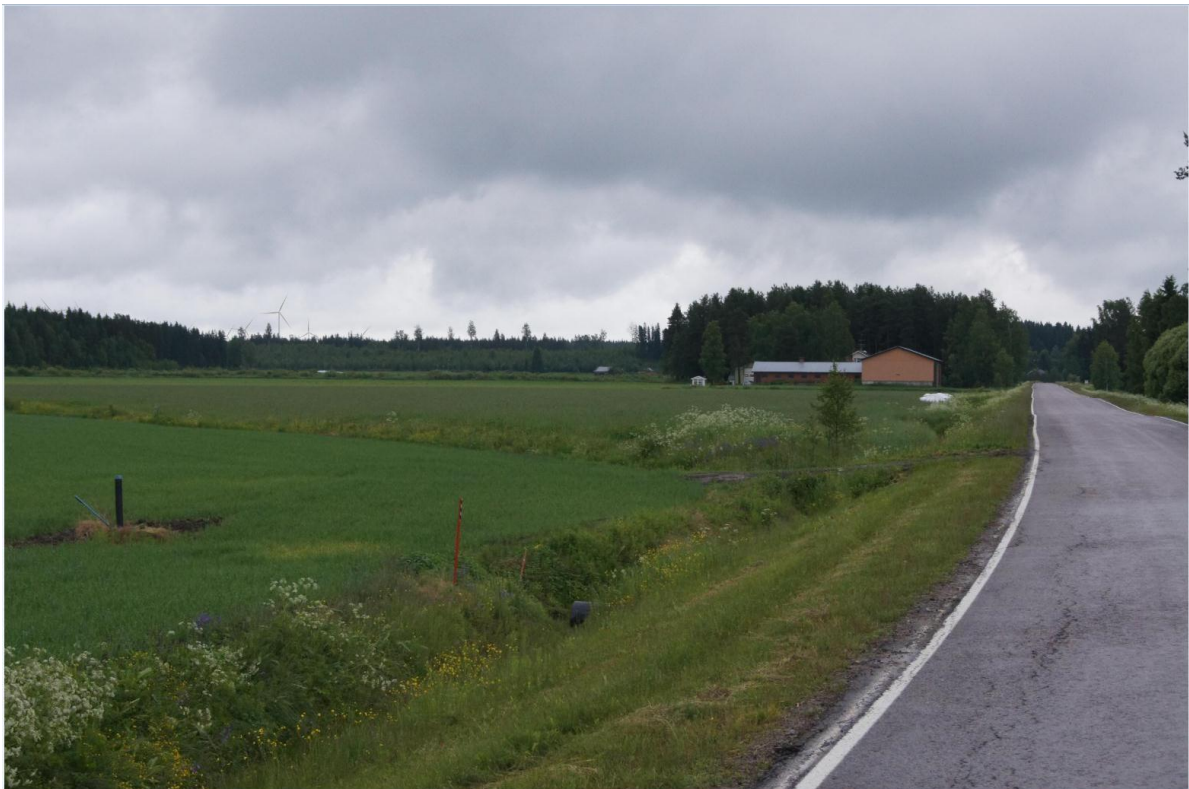
Kuva 47. Havainnekuva Puskalan kiinteistön kohdalta kaakkoon kohti tuulivoimapuistoa (VE2), polttoväli 55 mm. Etäisyyttä lähimpään kuvassa näkyvään voimalaan on noin 7,2 km.
