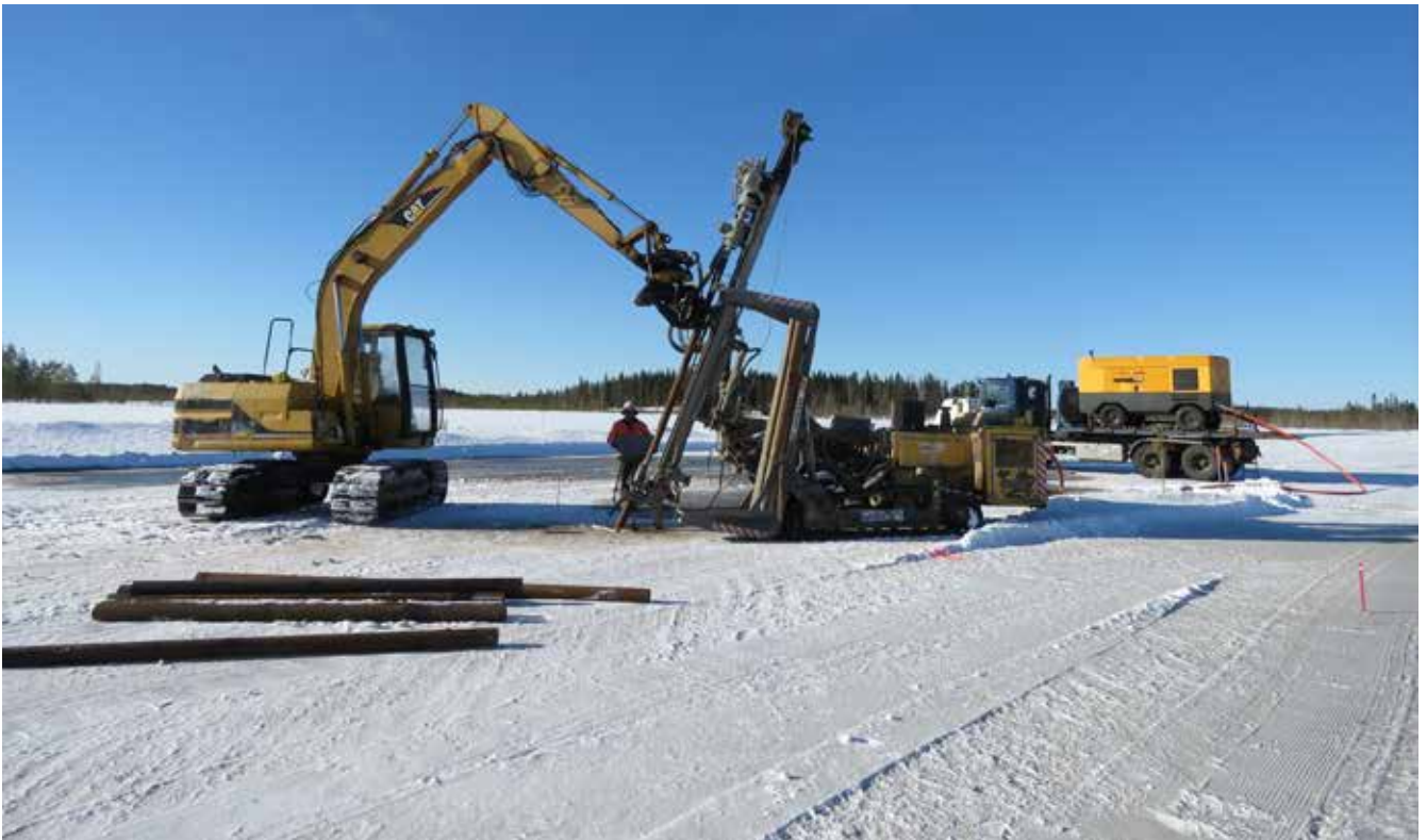
Kuva 6. Porapaaluperustuksen tekoa suoalueella, missä työalue on jäädytetty.
