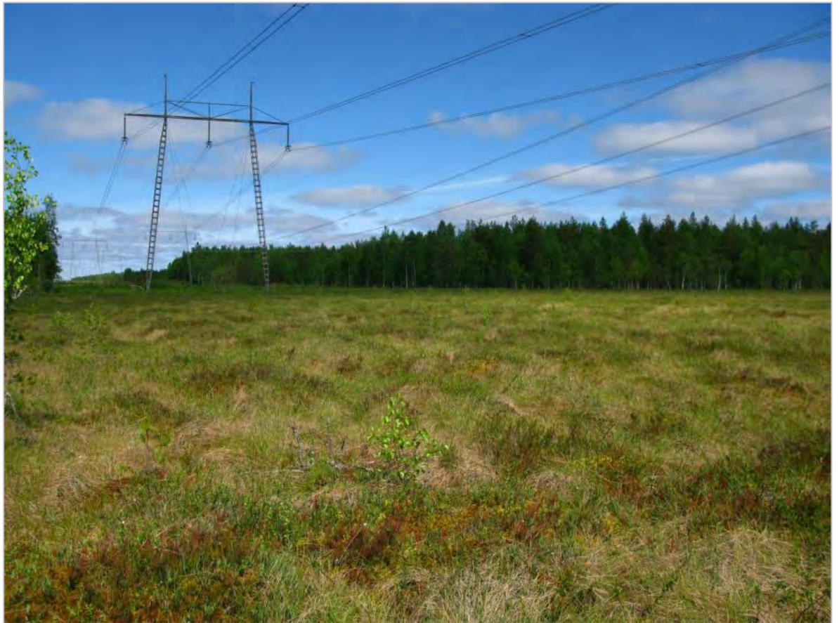
Kuva 28. Muurausnevaa suunnitellun voimajohdon kohdalla
