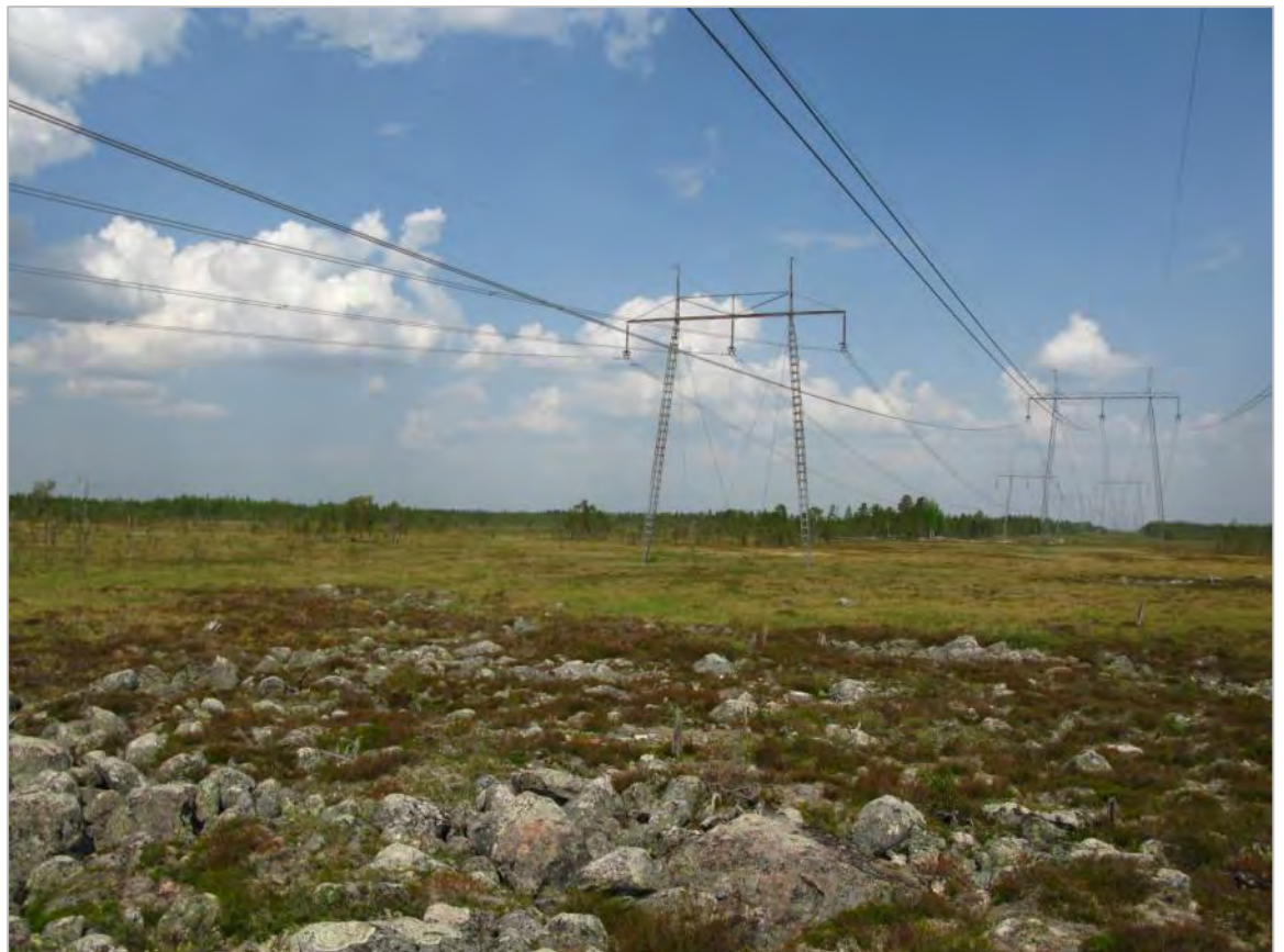
Kuva 17. Nykyiset 2x400 kV voimajohdot katajajärvennevalla.
