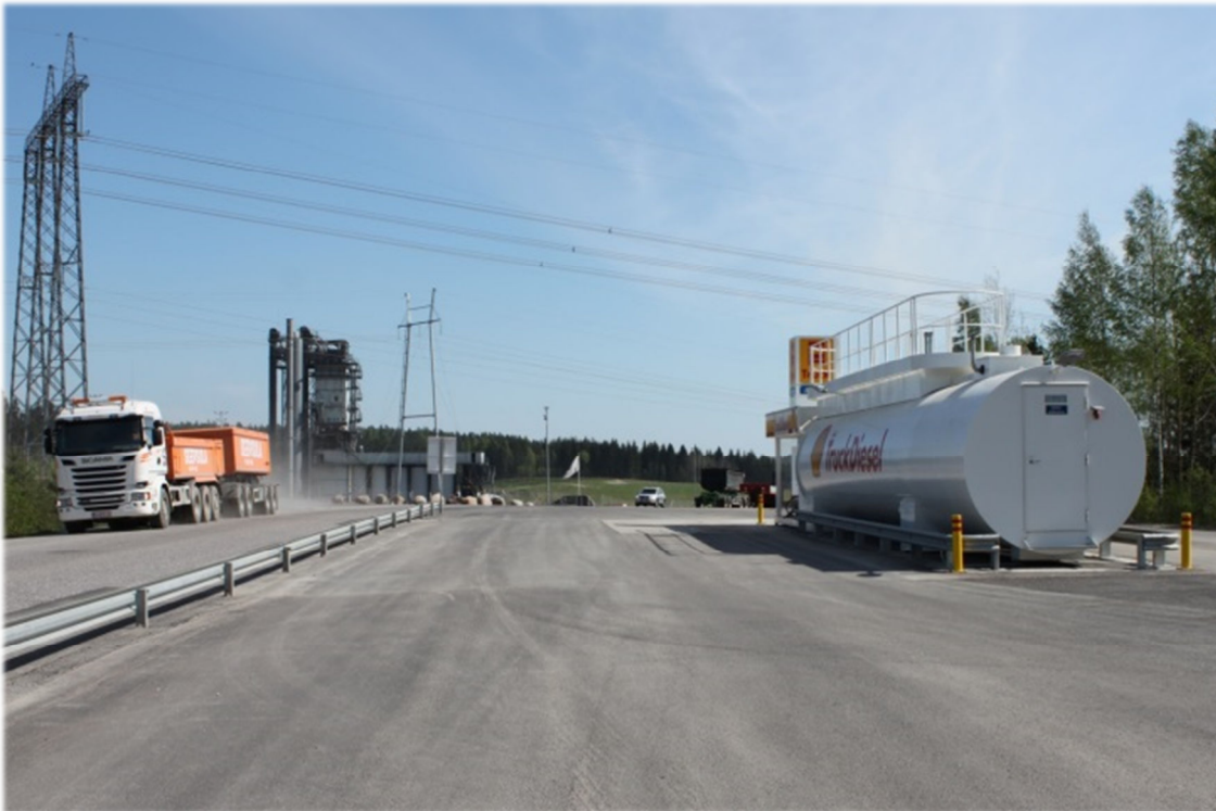
Kuva 4. Dieselpiste ja taustalla asfalttitehdas
