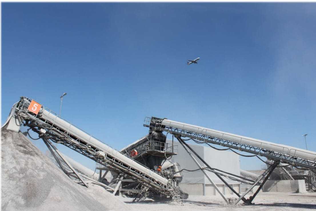
Kuva 2. Senkkerin kiviainestehdas on lentomelualueella. Alueen yli laskeutuu jatkuvasti lentokoneita Helsinki-Vantaan lentokentälle. Toiminnan louhinnassa tehdään jatkuvaa yhteistyötä lennonjohdon kanssa.
