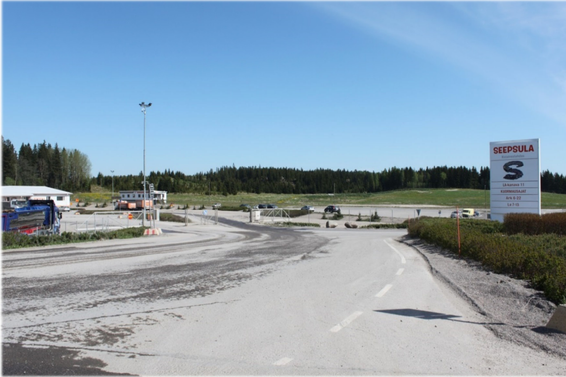
Kuva 3. Kulku Senkkerin tuotantoalueelle.
