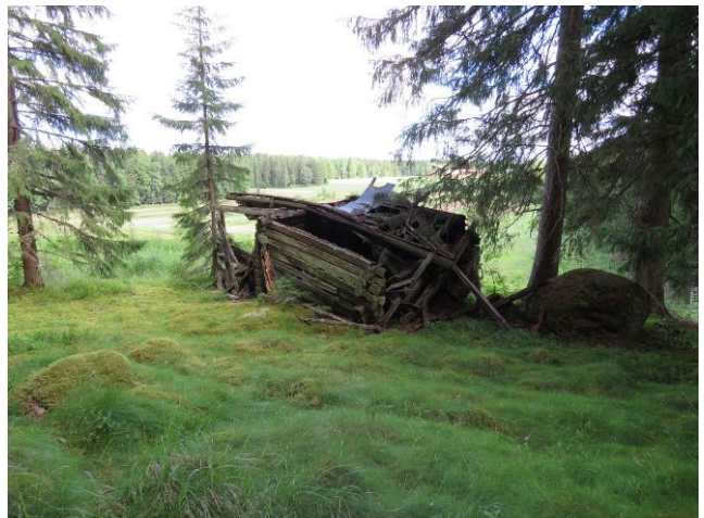
Romahtanut lato pellon reunassa, kuva pohjoiseen.
