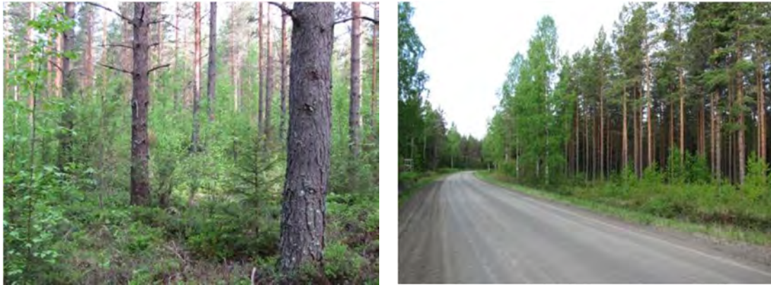
Kuva 2-4. Vasemmalla tuulivoimalan 1 rakentamisaluetta ja oikealla huoltotien liittymäkohta Uttermossantieltä (huoltotie lähtee kuvassa oikean eli lännen suuntaan).
