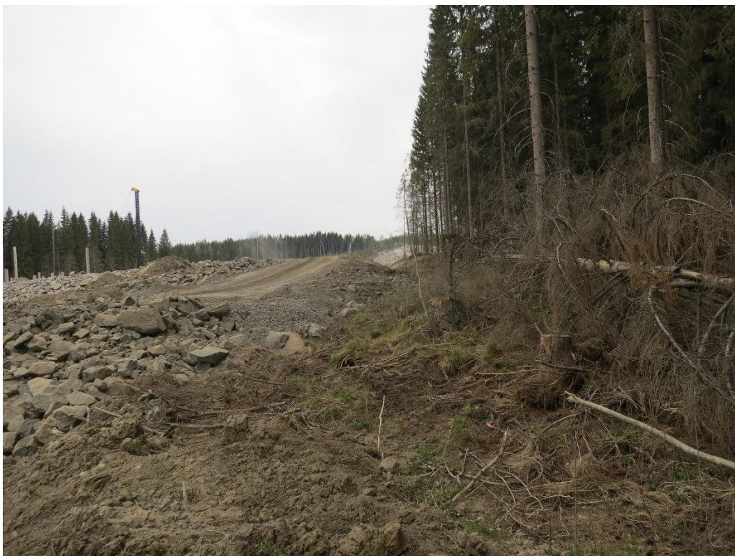
Kuva 14. Noin 1 km Kehätien hankealueen koillispuolella rakenteilla olevan kehätien puustoton aukko on ainakin Koivusillanjoen tienoilla niin leveä, että liito-orava ei kykene kulkemaan liitämällä aukon yli. Kuva länteen Koivusillanjoen itärannalta.
