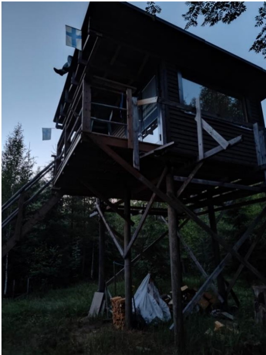
Kuva 4-1. Paikallisen metsästysseuran hallinnoima rakennus hankealueella.
