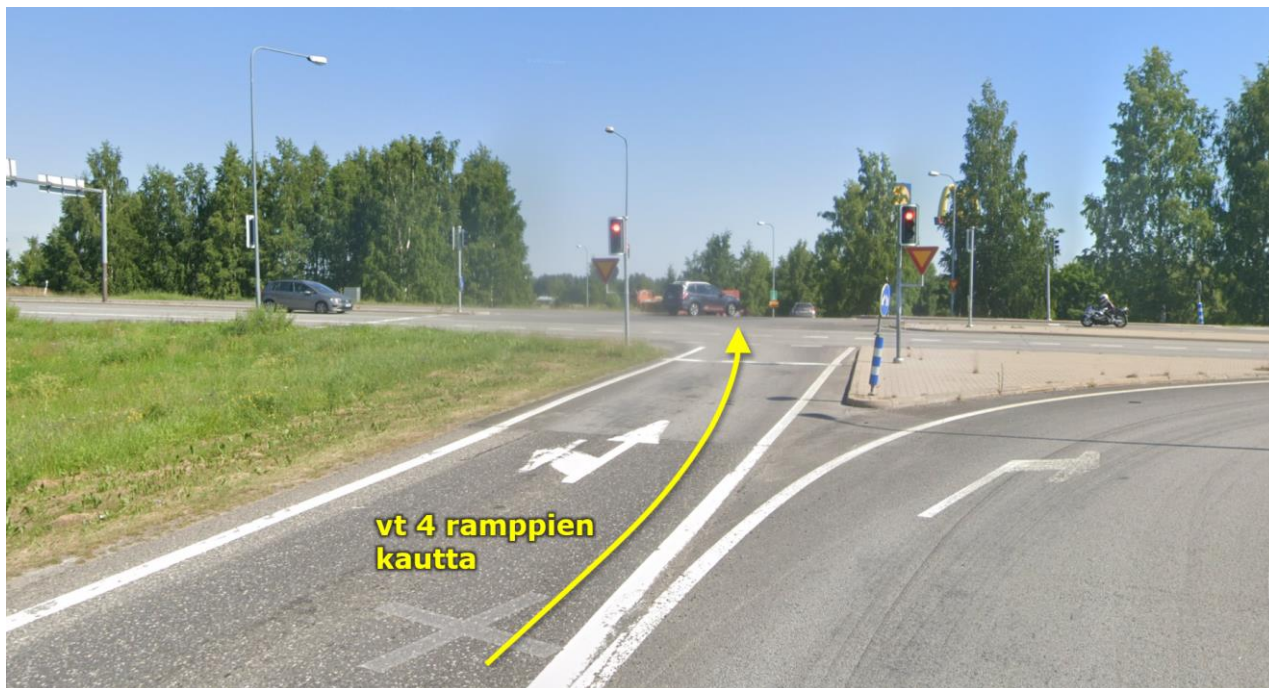
Kuva 5: Korkeat erikoiskuljetukset on liikennöitävä valtatie 4 ramppien kautta. Kempeleellä sijaitsevassa eritasoliittymässä (POS A1) on varmistettava tiegeometrian soveltuvuus lapakuljetuksille.
