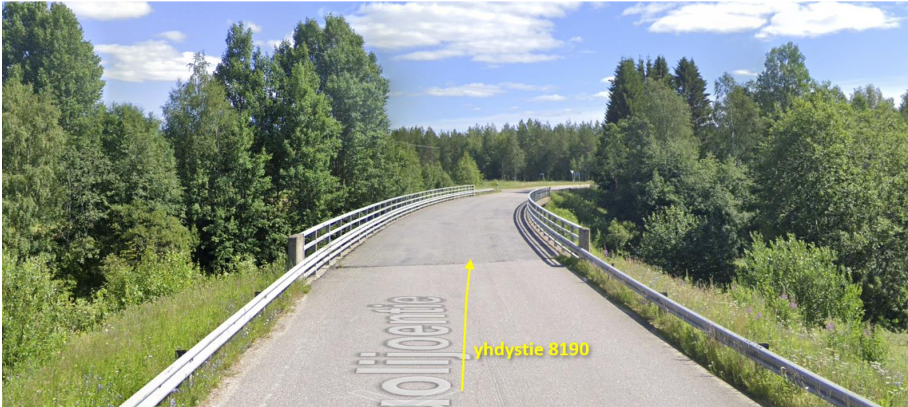
Kuva 21: Neittävänjoen silta yhdystiellä 8190 hankealueen länsipuolella (Google Maps 2024).
