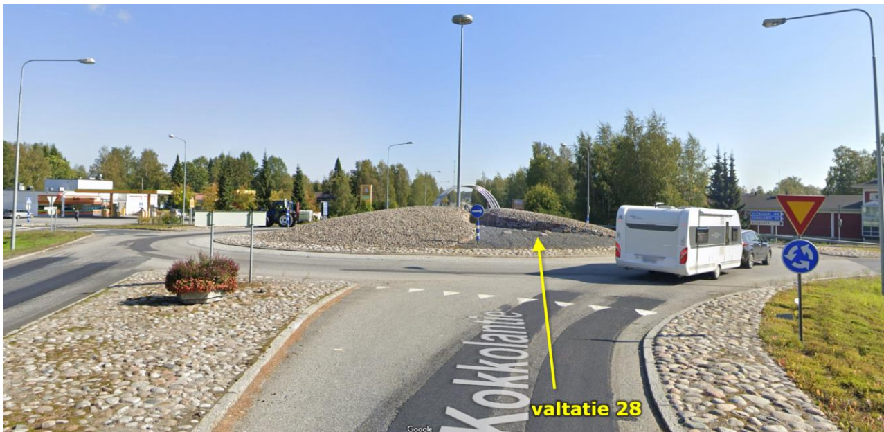
Kuva 8: Kiertoliittymä valtatiellä 28 Kannuksen keskustan kohdalla (Google Maps 2024).
