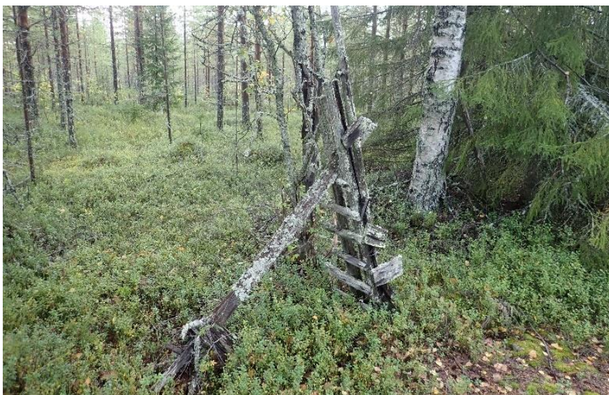
Kuva 77. Pelttarin Hukkasen poroerotuskentän aidan rakenteita. Pohjoiseen.
