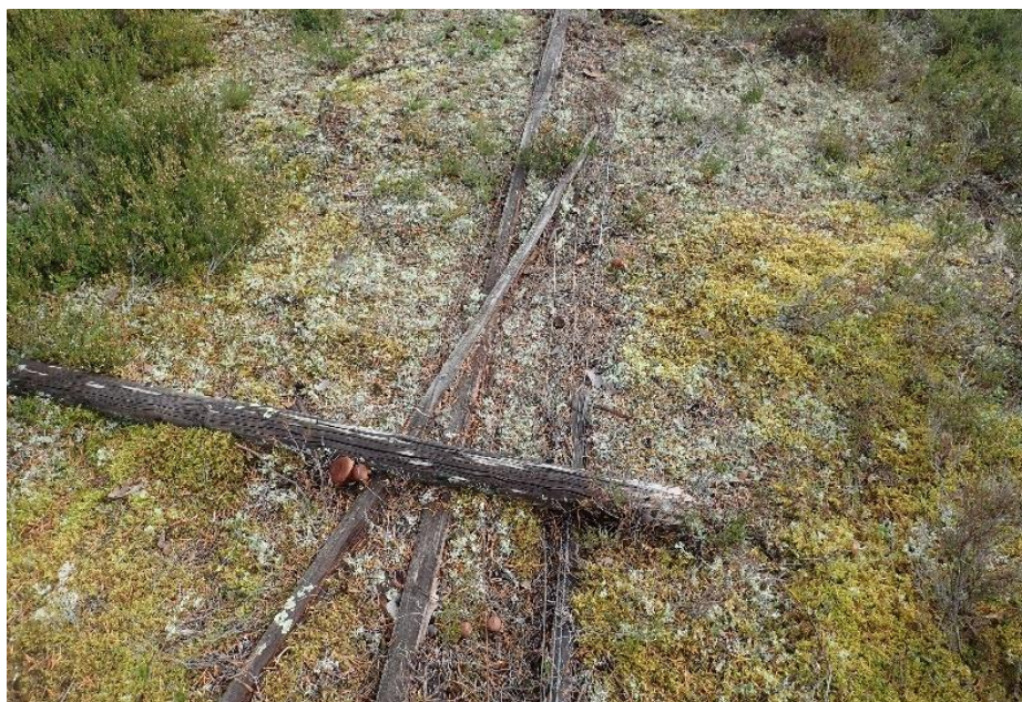
Kuva 81. Eteläosan aitarakennetta on vahvistettu metallilangoilla. Itään.
