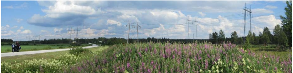
Kuva 44. Havainnekuva Saukonperän-Patakorven alueelta kantatien 28 varrelta kohti pohjoista. Pylvästyypinä käytetty putkimallia (Kuvanottopiste A).
