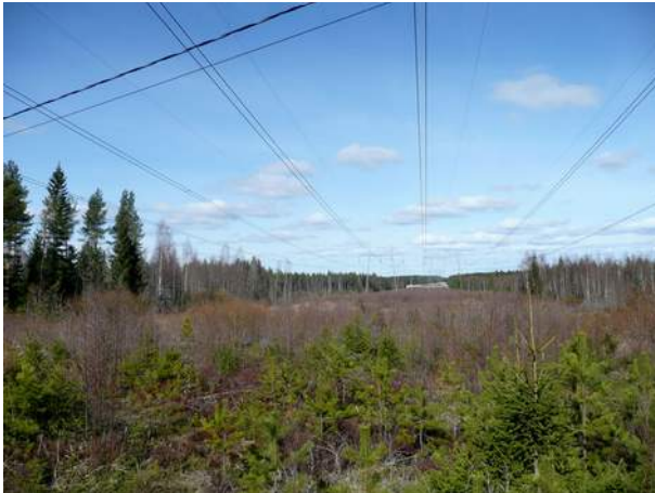
Kuva 15 Rajaperän kohdalla koilliseen.
