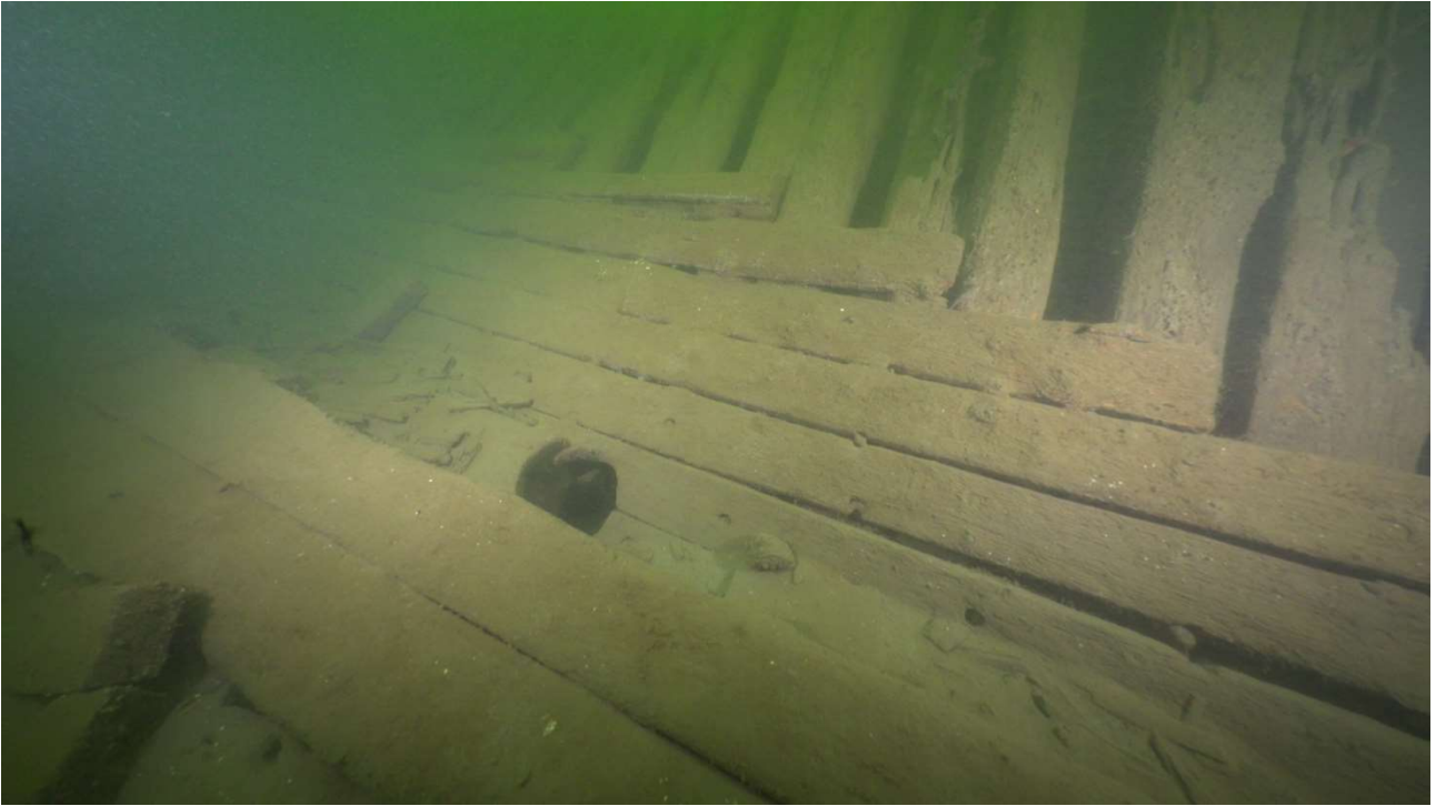
Kuva 33. Pilssipumpun reikä (halkaisija 23 cm) sikokölin vieressä, styyrpuurin puolella 6,5 m perästä.
