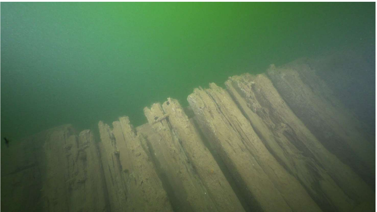
Kuva 38. Parikaaria styyrpuurin puolella perässä, mistä sisäkarneeraus on irronnut.
