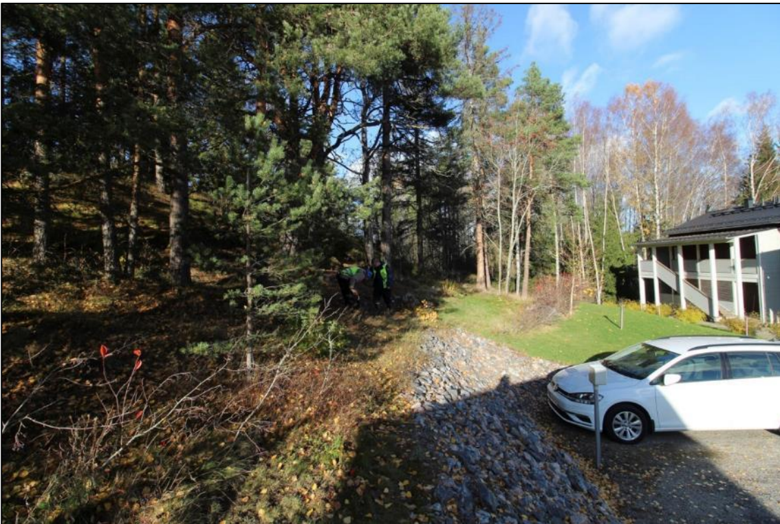
Porvoo Kunnalliskoti. Työkuva, koepistoja kaivetaan kallion viereen. Kuva etelästä. (AKDG7529:108)
