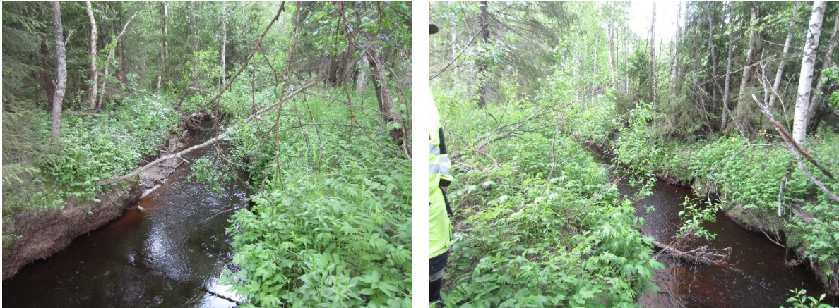
Kuva 4-36 Kiviojan uoma purkupuotken reitin kohdalla itärannalta kuvattuna.
