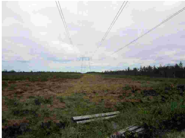
K10. Johtolinjaus ylittää Pikku Turkkisuon. Kuva luoteesta.
