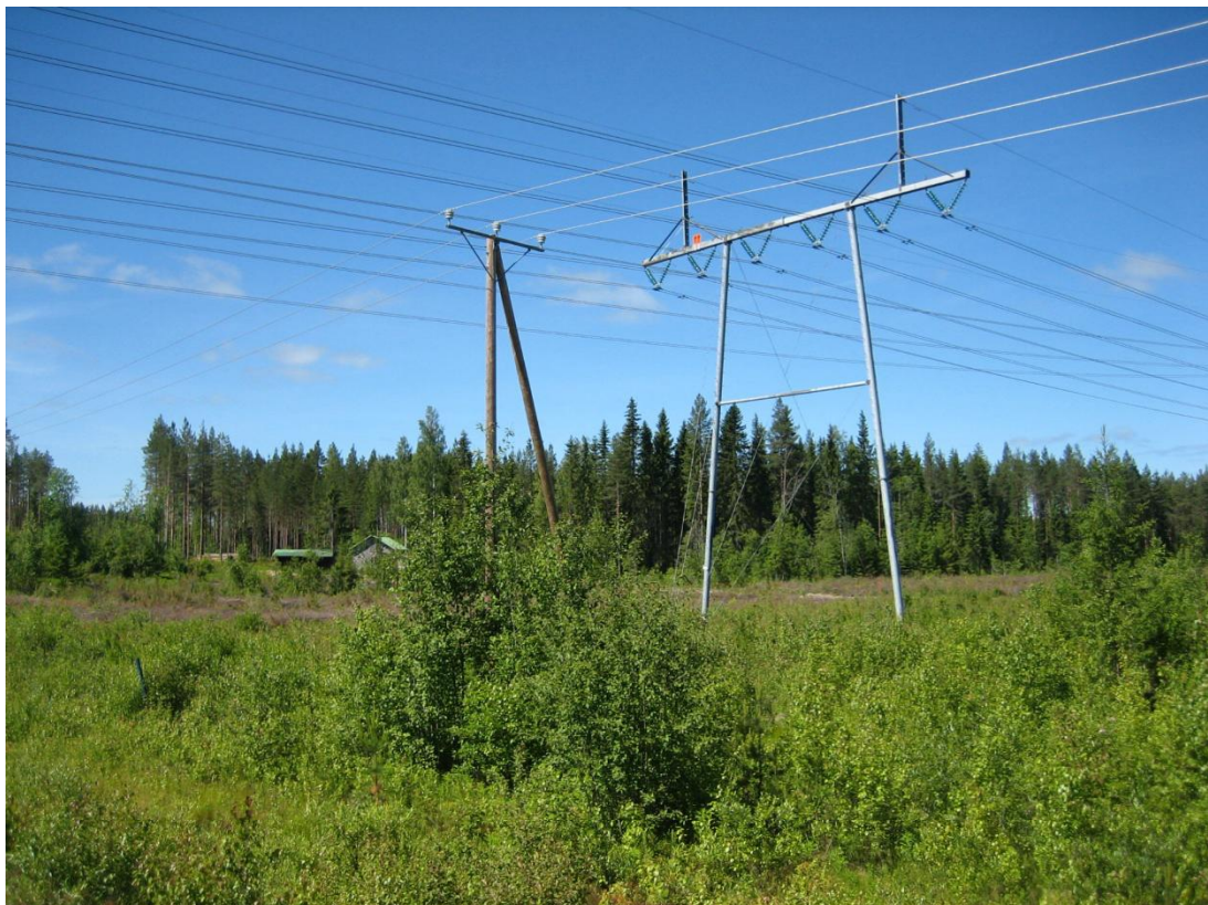
Kuva 24. Lähimpänä sijaitsevan asuinrakennuksen lähimaisemaa vallitsevat nykyiset voimajohdot.
