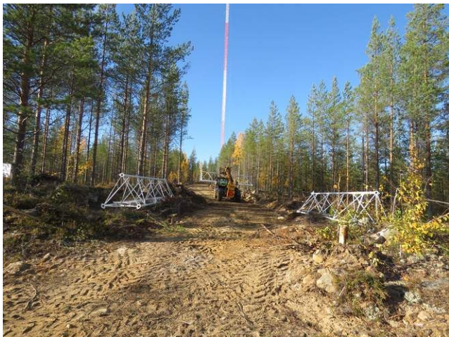
Kuva 27. Tulimittaustornin pystytys Isokankaan pohjoispuolella.
