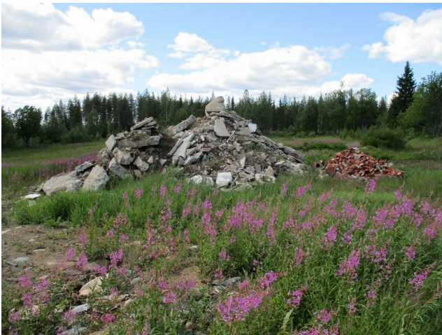
Kohde 31, alavasemmalla yhden purettun rakennuksen pohjaa, taaempänä keskellä rakennuksen purkujätettä kasoina; kuvattu länsiluoteeseen.
