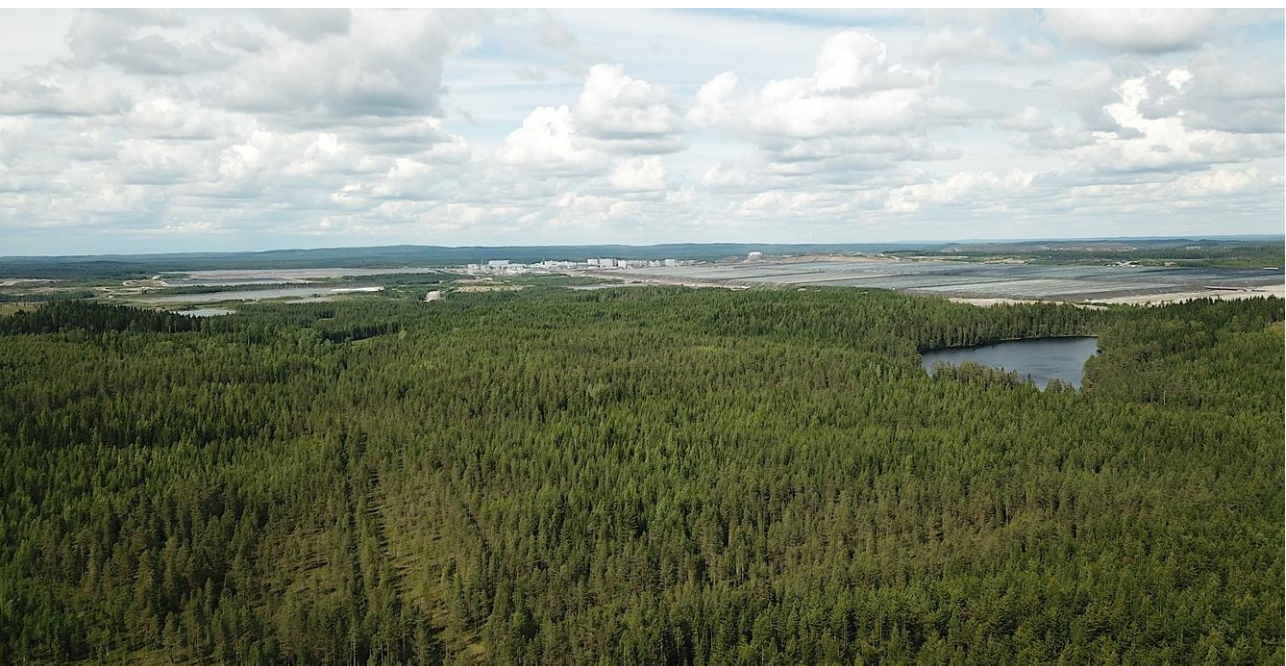
Kuva 31. Hankealue kuvattu luoteeseen Isolta Pukaramäeltä; ilmakuva, korkeus 120 m.
