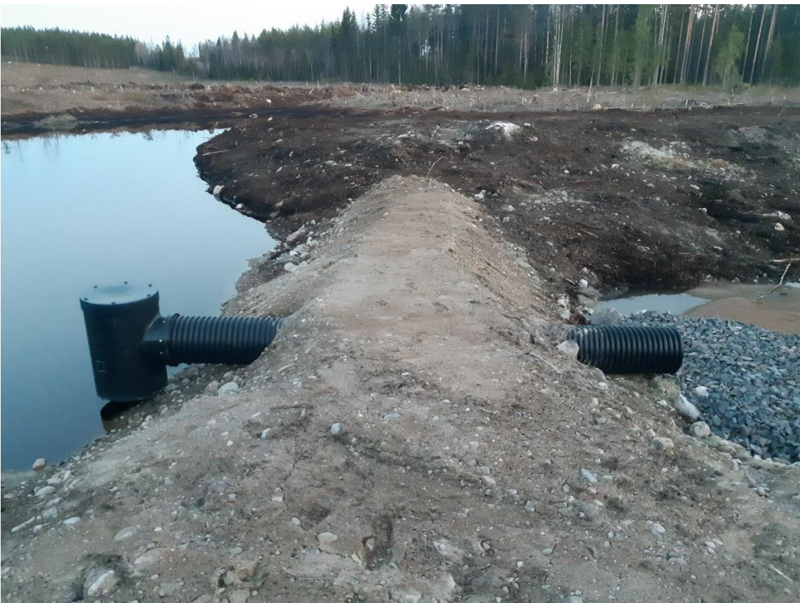
Kuva 7. Uuden hulevesialtaan rakenteita
