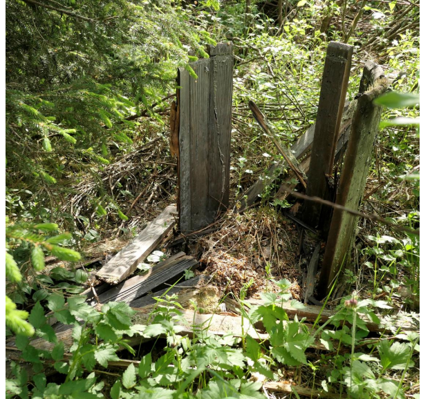
Kuva 4. Lehtikankaan lähdettä ei havaittu ja sen arvioidaan tuhoutuneen.
