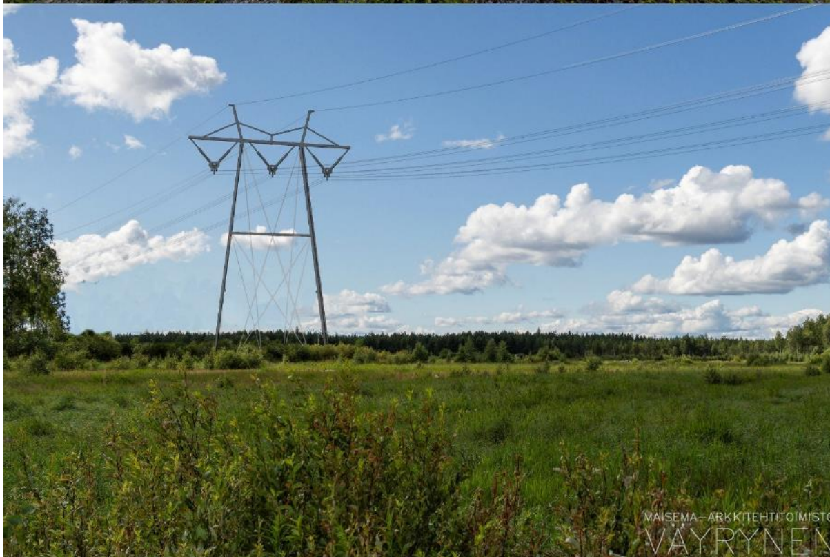
Kuva 1-49 (T). Näkymä Mökälän Sääksjärventieltä peltoaukean yli kohti voimajohtoja. Kuviin on mallinnettu vaihtoehdot SVE2A, SVE2B ja SVE2C. Yläkuvan objektiivi on 16 mm ja alakuvan 50 mm.
