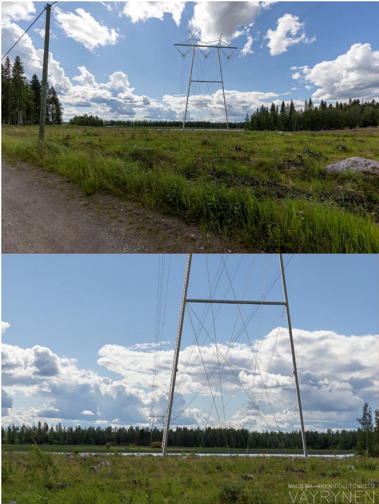
Kuva 1-47 (P). Näkymä Kinnulanlahdelle kohti voimajohtojen ylityskohtaa. Kuviin on mallinnettu vaihtoehdot SVE2A, SVE2B ja SVE2C. Yläkuvan objektiivi on 16 mm ja alakuvan 50 mm.
