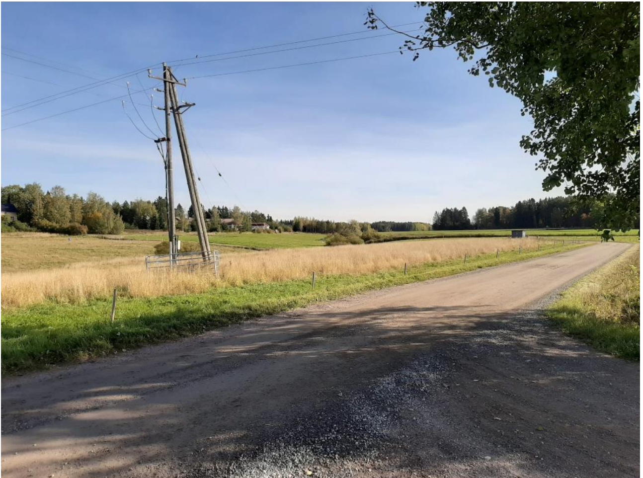
Kuva 2. Risteys Suutarlantie-Mäenpäänraitti: laajennusosat eivät näy tähän.
