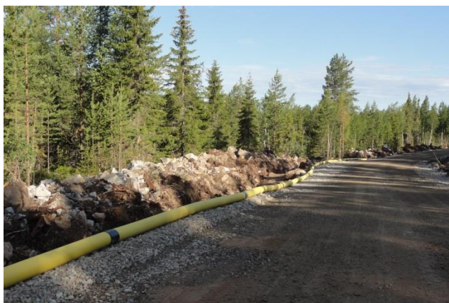
Kuva 14 Esimerkki tuulivoimapuiston rakennus- ja huoltotiestä. Teitä käytetään muun muassa betonin, soran ja voimaloiden komponenttien kuljetuksiin sekä tuulivoimapuiston käyttövaiheessa huoltoajoihin. Maakaapeli sijoitetaan ojakaivantoon tien reuna-alueelle (Kuva: Ville Suorsa / FCG)
