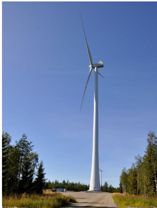
Kuva 15 esimerkki teräslieriötornista ja oikealla hybriditornista. (Kuvat: Leila Väyrynen, FCG)
