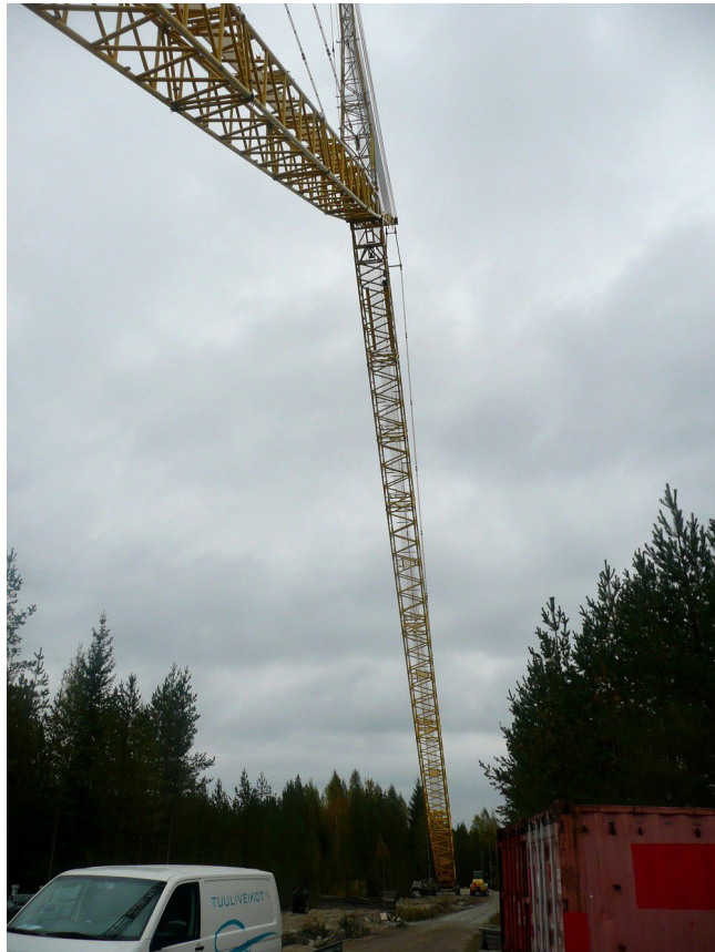
Kuva 13. Salon hankealue, nosturin puomi ja pystytystä varten tehty kaista.
