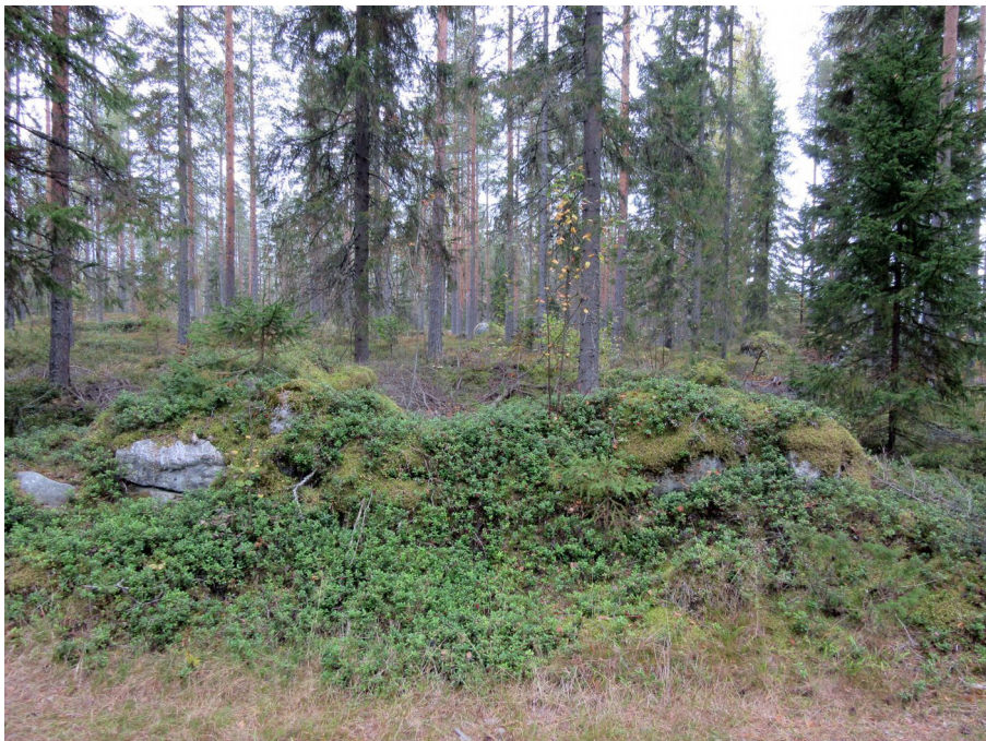
Rakennuksen perustus kuvattu etelästä.
