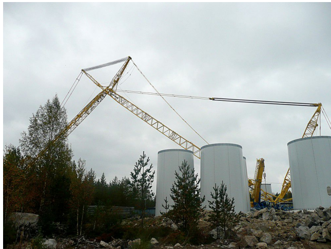
Kuva 12. Tuulivoimalan rakennustyömaa Salon hankealueen pohjoisosassa.
