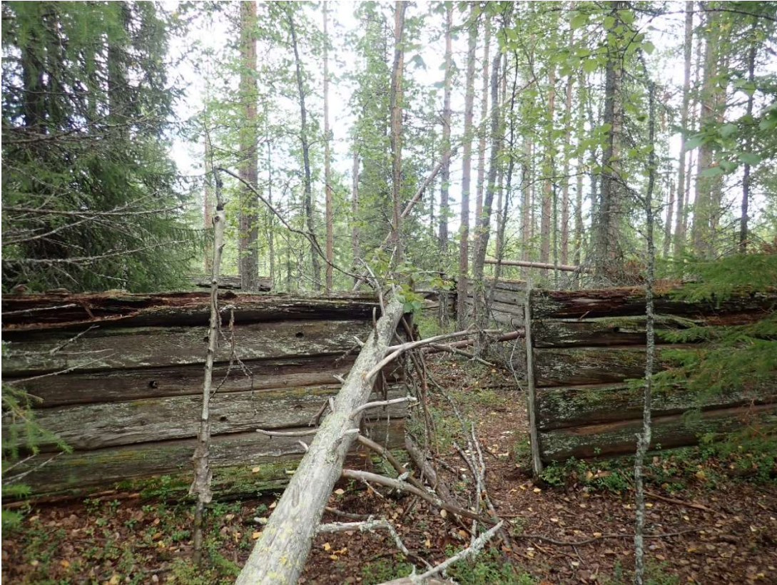
Kuva 21. Lutikkakummulla sijaitsevan kämpän seinälinjaa sekä oviaukko. Koilliseen.
