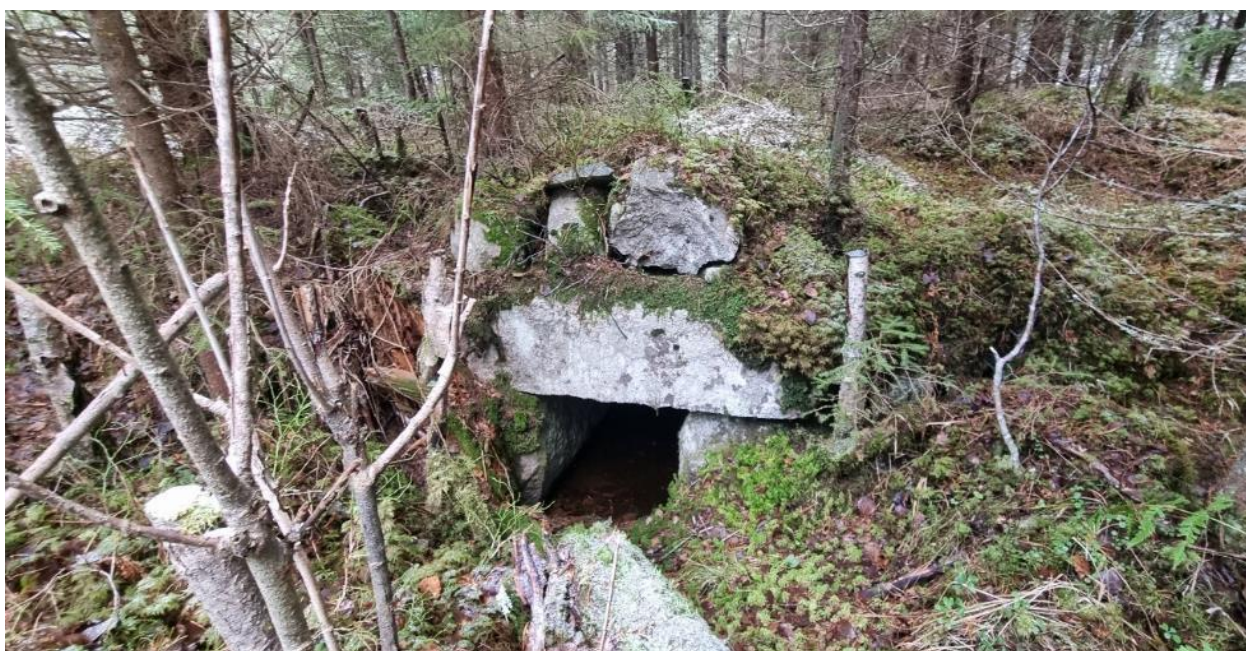
Kuva 21. Pois käytöstä jääneen tien kohdalla sijaitsee lohkotuista kivistä tehty siltarumpu. Kuvattu luoteeseen.
