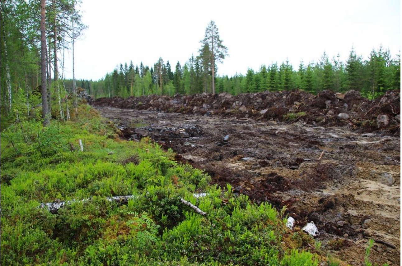
Kuva 4. Aluetta 1. Keliberin kaivoksen huoltotie rakenteilla kesäkuussa 2022 Hoikkanevan hankealueen länsireunalla. Kuva 22.6.2022. Kuivahkoa mäntyvaltaista sekametsää, aluskasveina mustikka ja puolukka.
