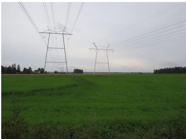
20. Johtoreitti SVE C Munakantieltä etelään.
