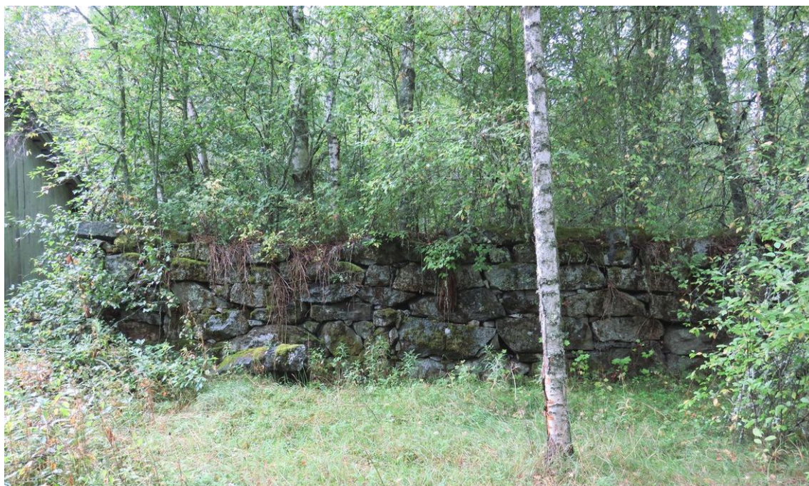
Navetan kivijalan itäseinämä, kuva länteen.
