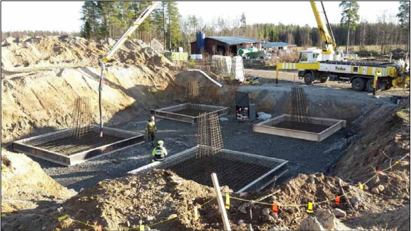
Kuva 8. Vapaasti seisovan pylvään perustuksen pohjatöitä.
