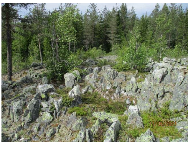
Kohde 1. Louhittua kalliota keskimmaisella kallioalueella. Kuvattuna luoteeseen.
