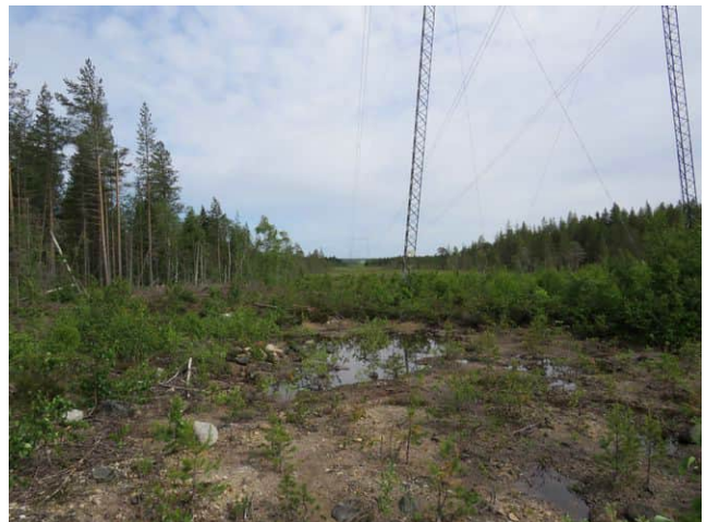
Kuva 26. Voimalinja Yhteisenlehdosta, kuvattu itään.
