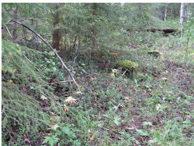
Kohde 4. Kämpän perustuksen betonijalkoja.
