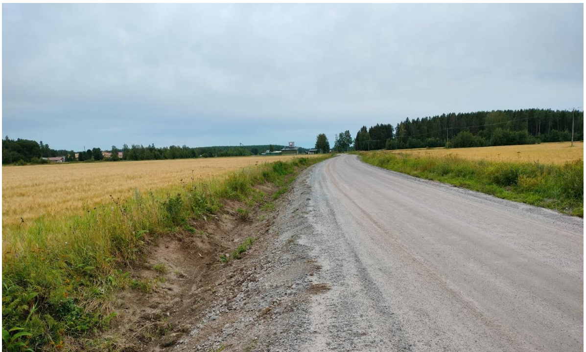
Kuva 21. Vöyrinjokilaakson kulttuurimaisemassa voimajohtoreitti sijoittuu peltomaisemaan ja teiden reunaan. Vöyrinjoen länsipuolella voimajohto sijoittuu Bertby-Lålaxvägen reunaan.
