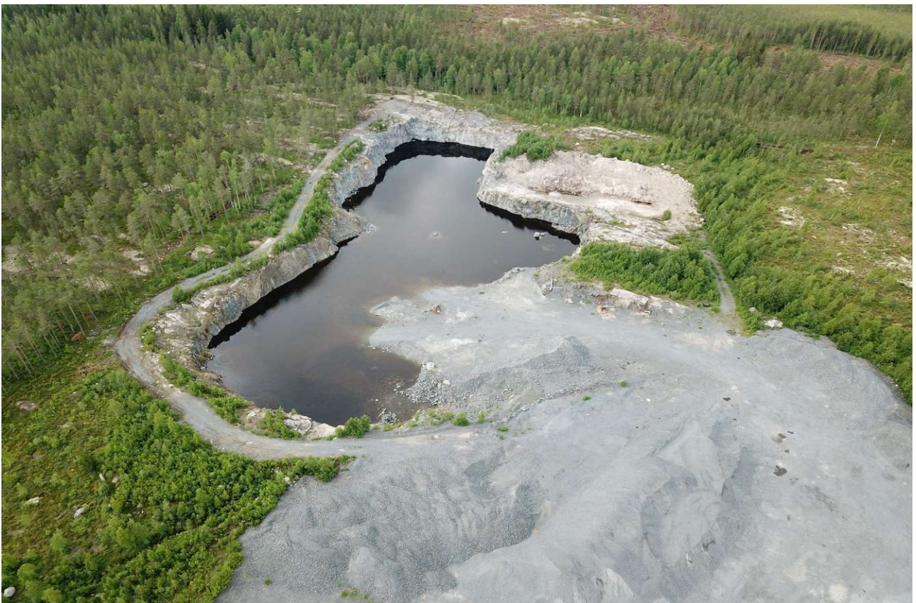
Kuva 2. Louhos hankealueen luoteispäässä. Dronekuva, korkeus 110 m.
