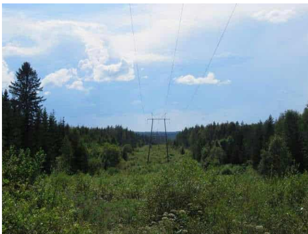
Kuva 56. VE A 1 ja 2. Linjaus Raippamäellä, koilliseen.
