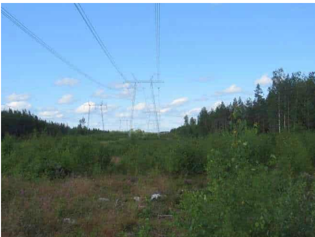
Kuva 25. Linjaus Kolumnevan kohdalla. Pohjoiseen.
