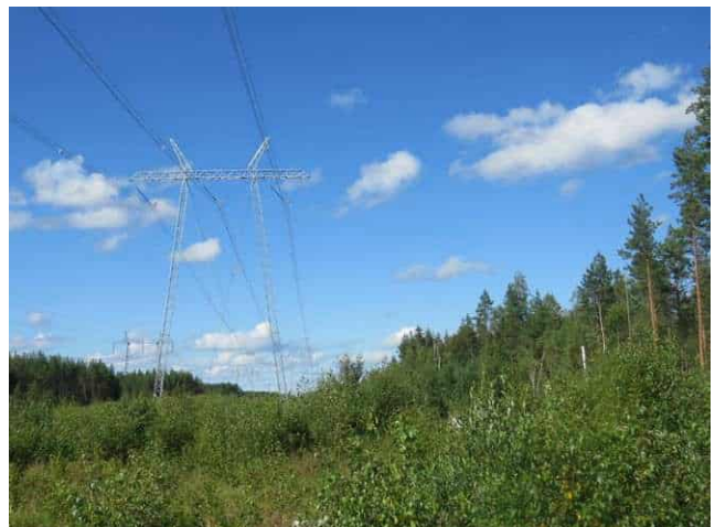
Kuva 26. Linjauksen eteläpää Tiensuunnevan pohjoispuolella.
