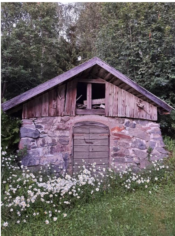
Kuva 25. Maakellari on mahdollinen lepakoiden talvehtimispaikka. Se kuuluu luokan I alueeseen.
