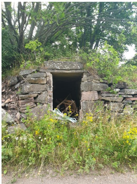
Kuva 23. Maakellari Tahkoluodossa oli ainoa linjan alla sijainnut rakennus. Se sopisi mahdollisesti lepakoiden syys- tai kevätpiiloksi. Kellarista ei kuitenkaan löytynyt lainkaan lepakoiden ulosteita, joita lepakoiden käyttämissä paikoissa tyypillisesti aina on © V.Vasko.
