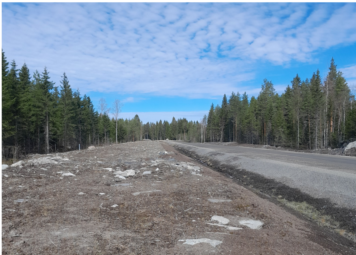
Kuva 4. Rikastetien länsipuolen tasoitettu alue. Etelästä. Kuva: Taneli Leinonen.
