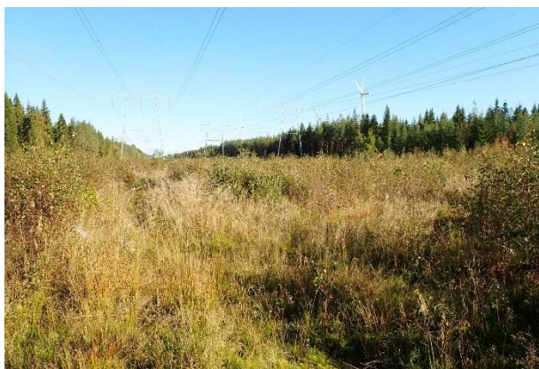
Kuva 9. Linjaa Paskoonharjun kohdalla.
