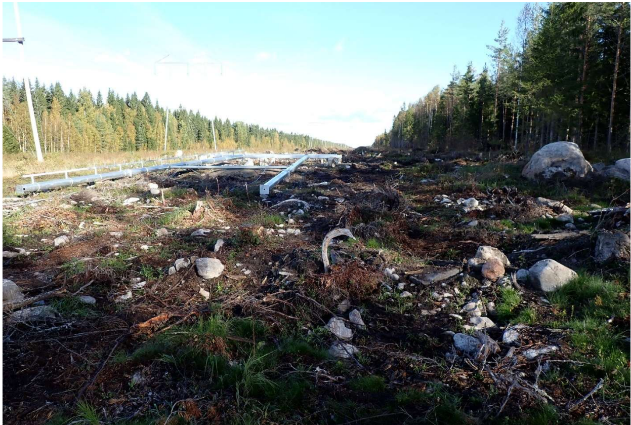
Kuva 7. Uutta linjaa rakenteilla Kinnasharjun laidassa. Paikalla on matala muinaisrantatörmä, mutta kivisyys ja kostea maaperä ei tee siitä kovin houkuttelevaa esihistorialliselle asutukselle.
