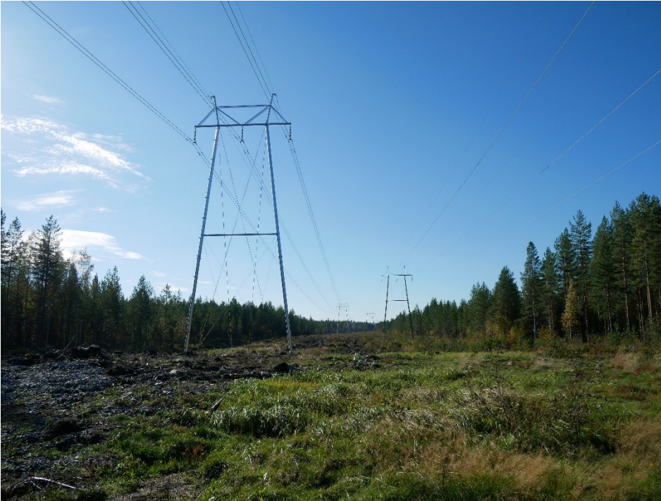
Kuva 76 Nykytila lounaaseen voimajohtolinjalta kohti Möksyn asemaa.
