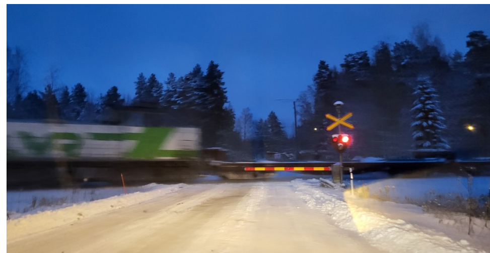
Kuva 101 Rautatie Inhantehtaantien ylityskohdalla
