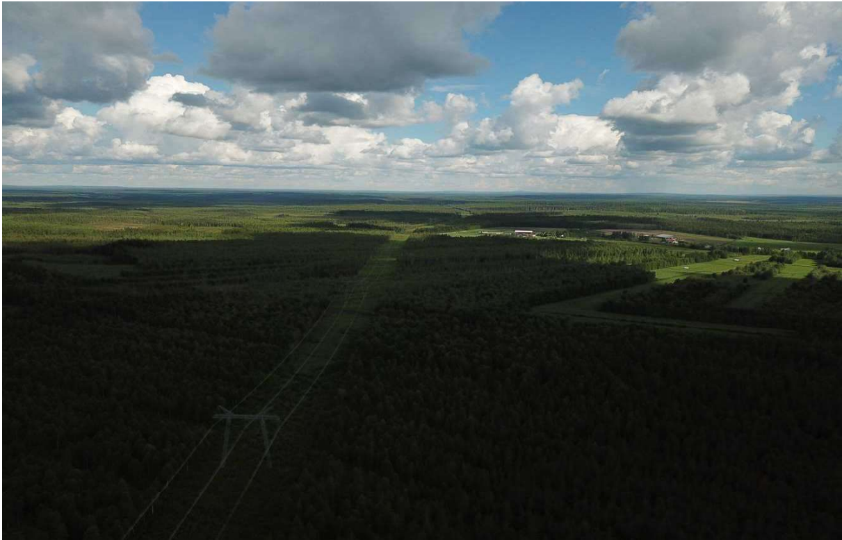
Kuva 48. Linjakäytävä Viitakoskelta pohjoiseen. Dronekuva, korkeus 115 m.
