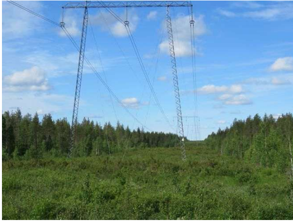
Kuva 58. Linjaus Santalammen eteläpuolella.
