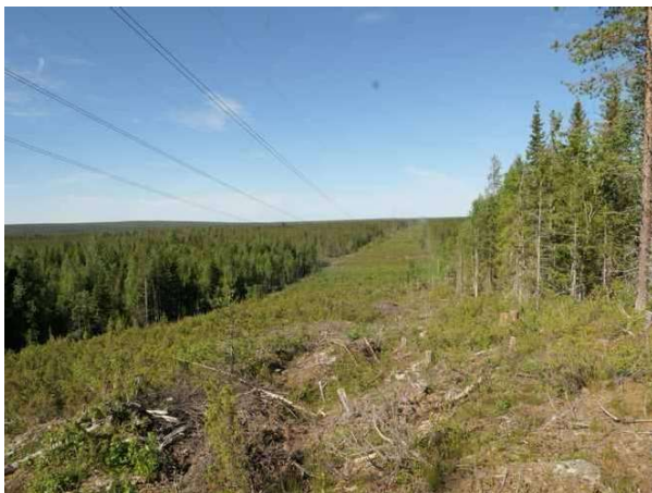
Kuva 15. Voimalinja hankealueen keskiosassa, länteen.
