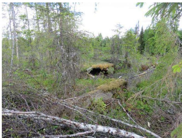
Kohde 5-1 talon betoniperustus
