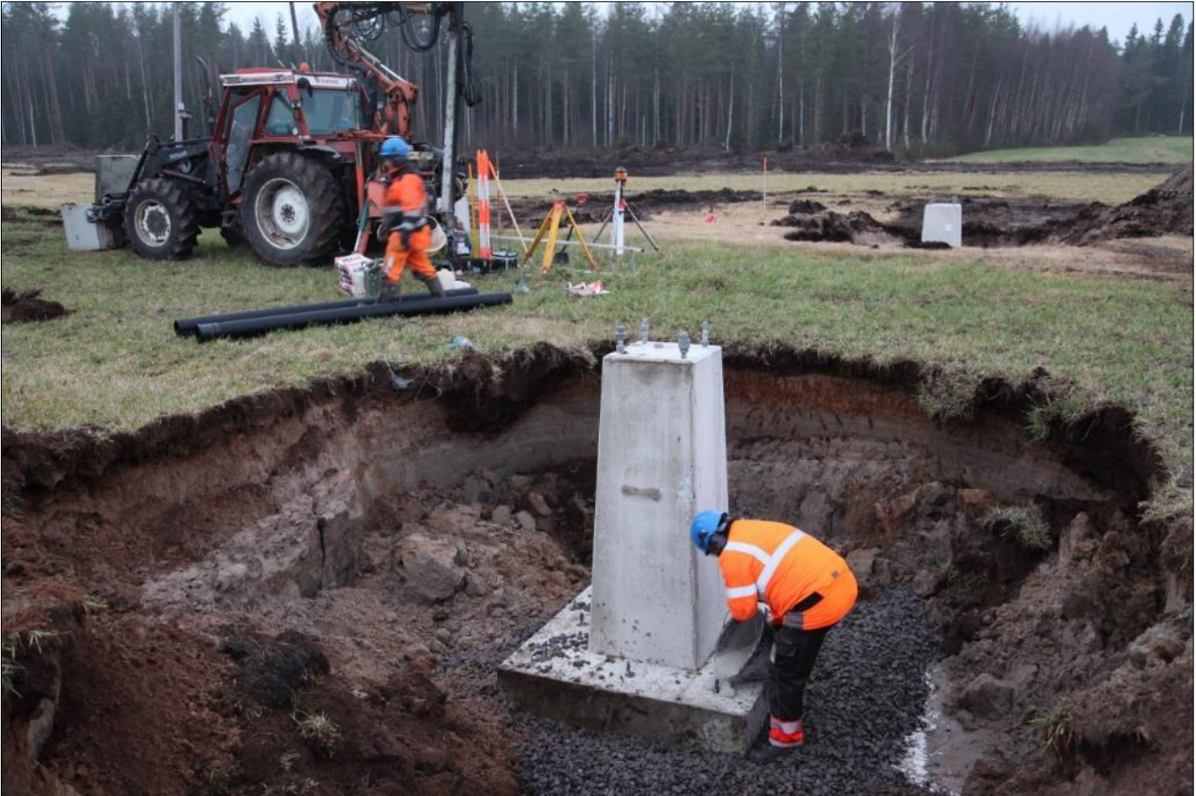
Kuva 8. Pylvään perustuselementin asentaminen.
