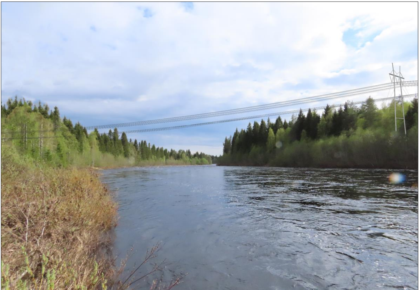
Kuva 114. Havainnekuva Siuruanjoen suuntaisesti Kankaalassa. Petäjäskoski-Nuojuankangas voimajohto on etualalla ja sen rinnalle sijoittuu rakenteilla oleva Viitajärvi-Pyhänselkä voimajohto.
