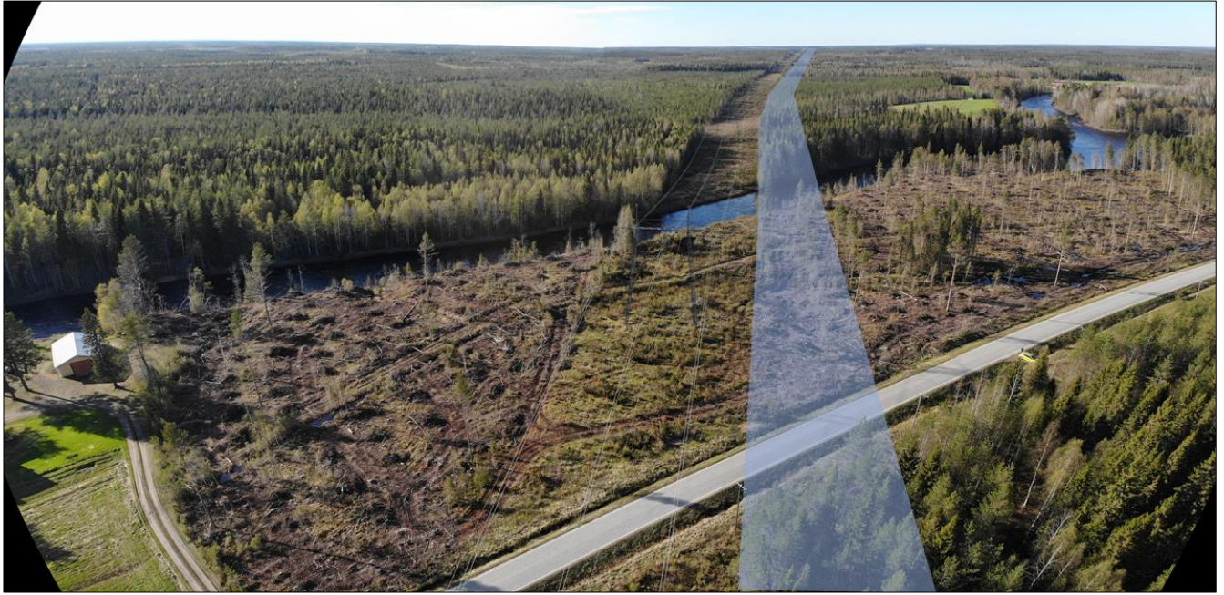
Kuva 110. Kuivajoen ylityskohta Koivuniemessä Vainion kohdalla. Varjostus kuvaa levenevää johtoaluetta.
