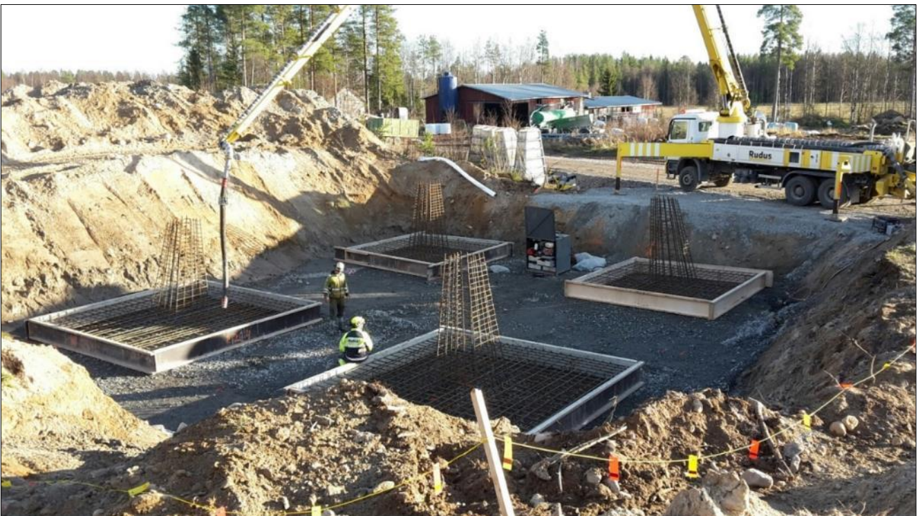
Kuva 9. Vapaasti seisovan pylvään perustuksen pohjatöitä.
