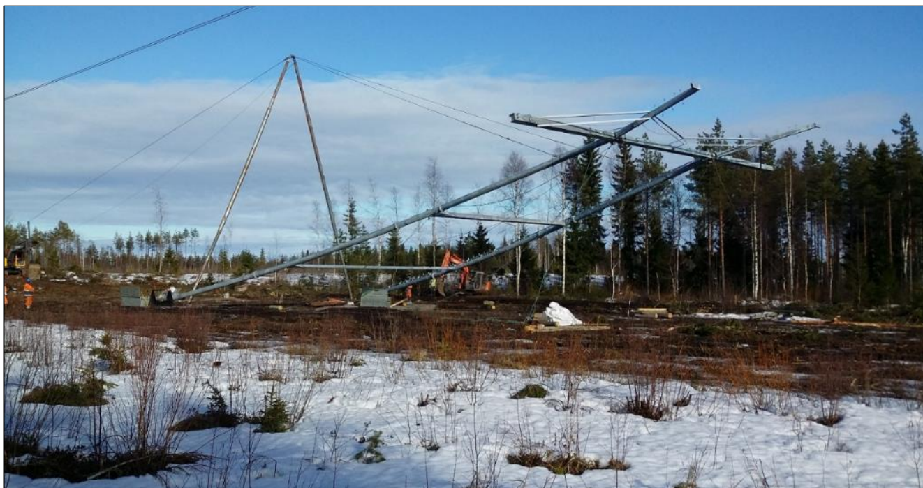
Kuva 10. Voimajohtopylvään pystytys.
