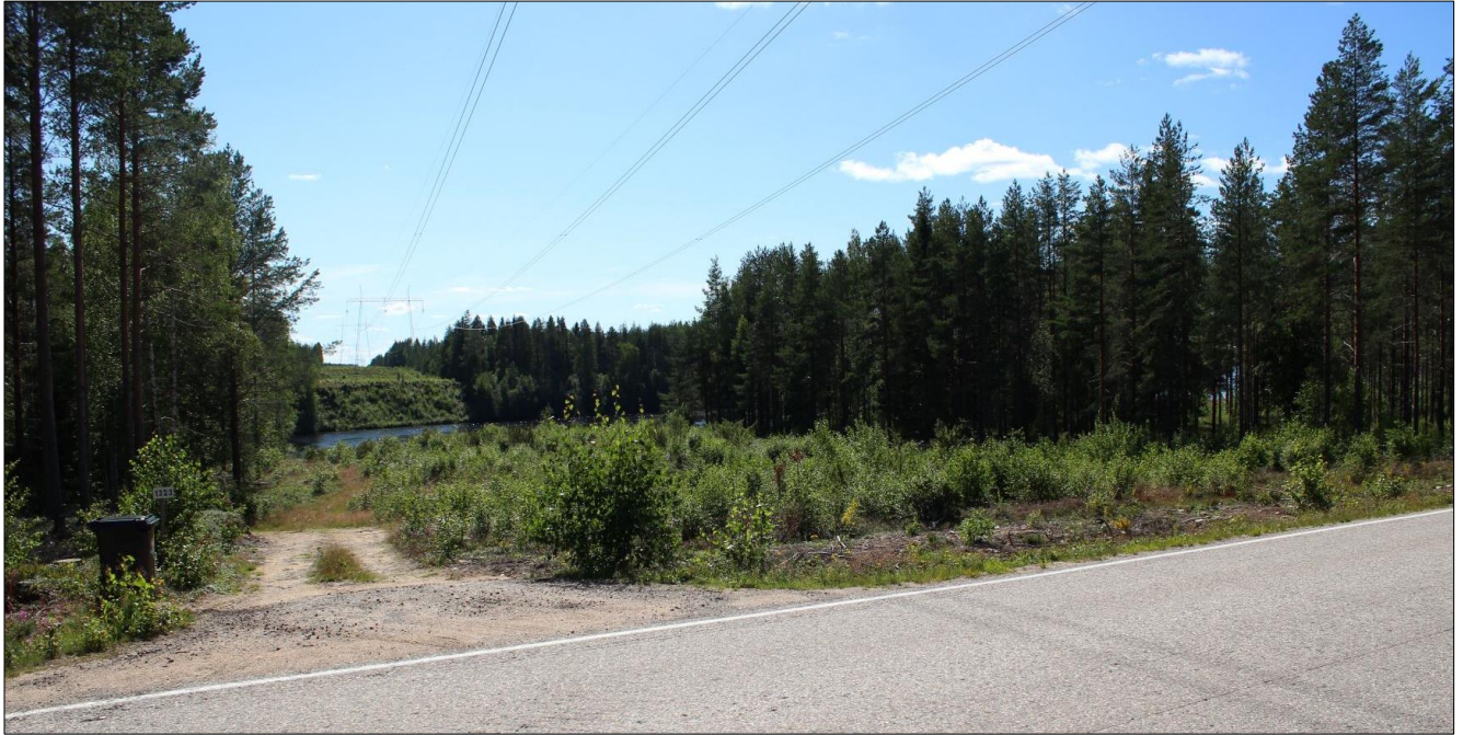
Kuva 121. Ijoen ylityskohta Pankinahossa on Herva – Arkala itäisellä reittiosuudella kapeampi ja peitteisempi kuin läntisellä reittiosuudella. Paikallisesti kaksi rinnakkaista voimajohtoa muuttavat jokimaisemaa rakennetumaksi, kun puustosta vapaa alue levenee.
