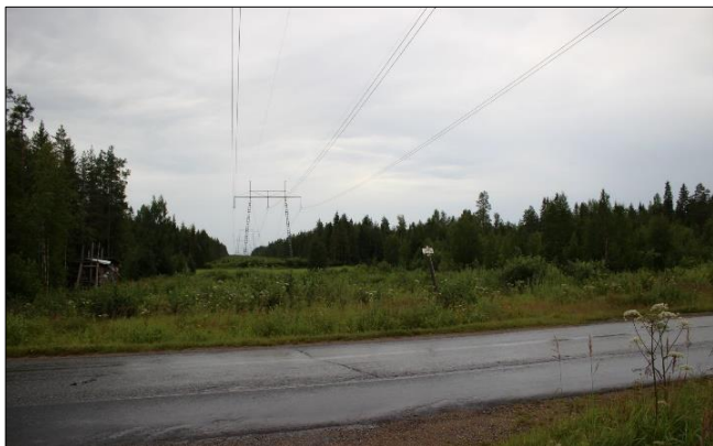
Kuva 107. Näkymä Olhavanjoen ylityskohdassa Tuomelassa, Tuomelan aseman alueella. Maisemakuva on osittain peitteistä, mutta kaksi rinnakkaista voimajohtoa muuttavat jokimaisemaa paikallisesti rakennetummaksi, kun puustosta vapaa alue levenee.
