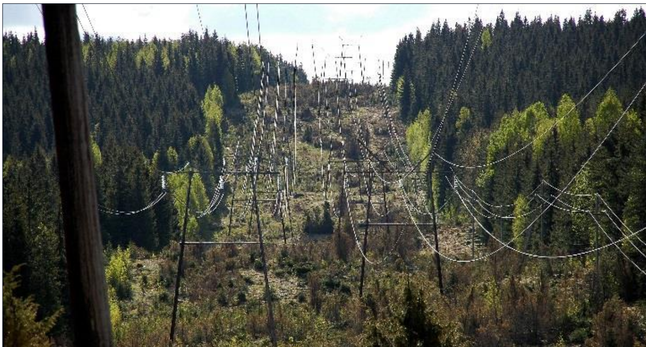
Kuva 11. Esimerkki valikoivasta raivauksesta.
