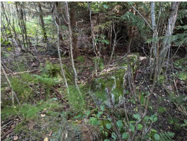
Alakohde 15-10, kuvattu itään. Rakennuksen kaakkoisnurkka, perustus ladottu isoista lohkokivistä.
