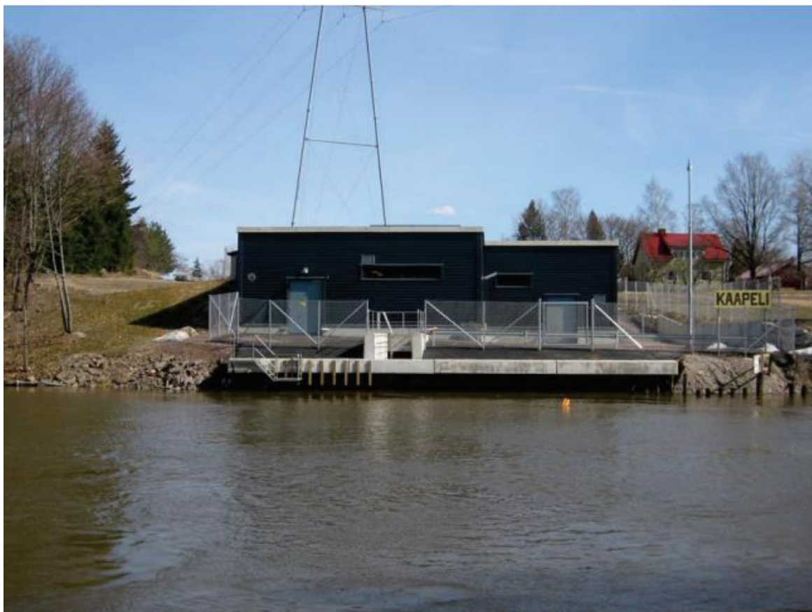
Kuva 4-1. Korkeakosken Hyötyvoimalaitoksen pumppaamo. Jäähdytysvesi puretaan noin 2 metrin syvyyteen pumppaamon edustalle. (Lähde: Kymijoen vesi ja ympäristö ry 2010)
