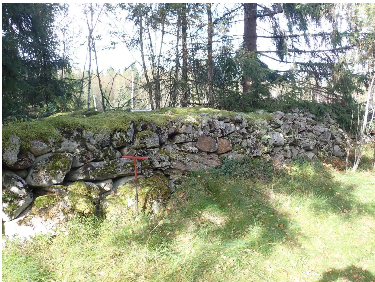
Kuva 13. Kiviaita sähkönsiirtolinjalla Vattumossantien varrella, Kaitåsintieltä noin 70 m länteen. Z 75. Kuva koilliseen.
