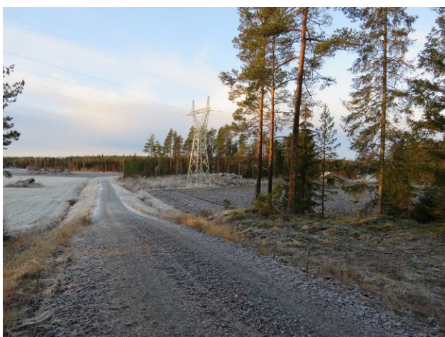
26. Johtolinjaus Kärkinemossenin pohjoispuolella.
