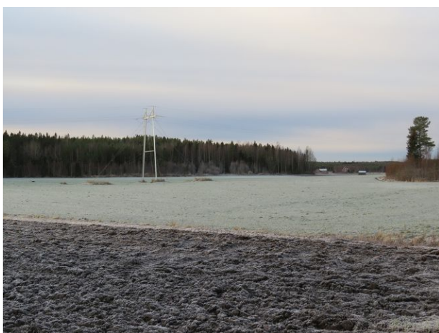
24. Johtolinjaus Leukuksen eteläpuolella.
