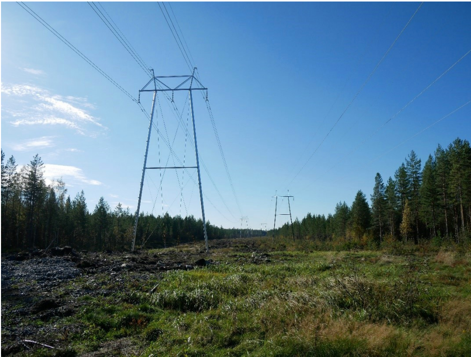
Kuva 107 Nykytila lounaaseen voimajohtolinjalta kohti Möksyn asemaa.
