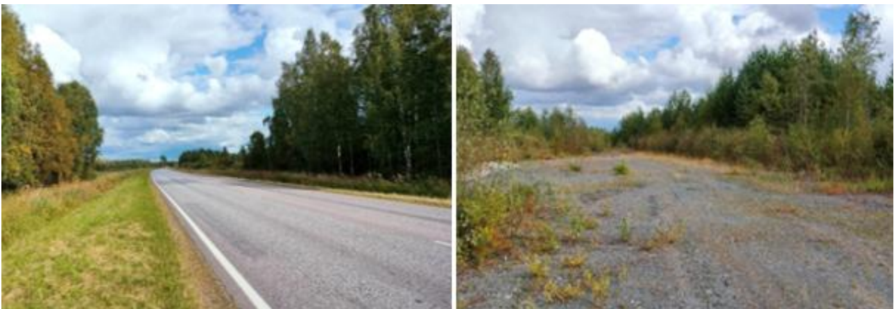
Kuva 51. Maakaapelireitti risteää Kajaanin tien kanssa ja sijoittuu tien eteläpuolelle (kuvassa vasemmalla). Kajaanintien ylityksen jälkeen johtoreitillä on joutomaa-alueita (oik).
