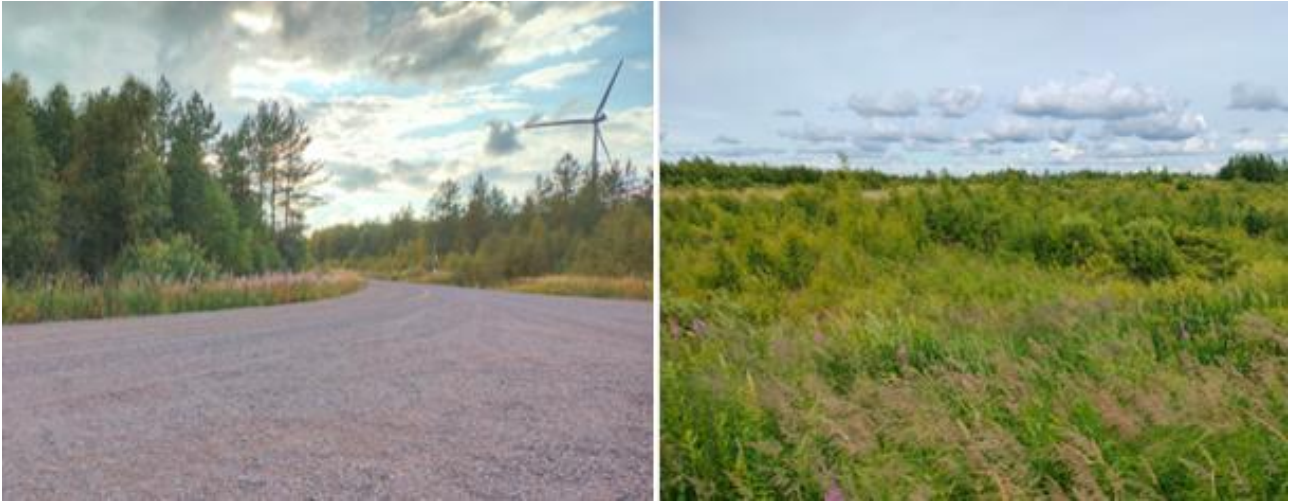
Kuva 52. Maakaapelireitti risteää tuulivoimaloille menevän tien kanssa Hankilan laajennusalueen keski-osassa (vas). Patanevan eteläpuolella maakaapelireitti sijoittuu joutomaaluonteiselle, pensastoiselle alueelle, joka on entistä turvetuotantoaluetta. Alueella on leveitä valtaojia.
