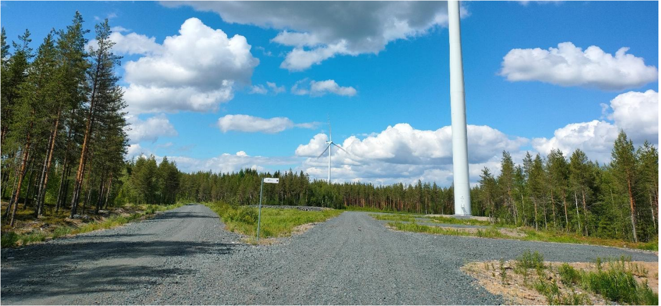
Kuva 34. Keson tuulipuiston alueella voimalapaikat, nostoalueet ja useat rinnakkaiset huoltotiet muodostavat laajoja avoimia alueita, joiden reunat ovat joutomaaluonteiset.
