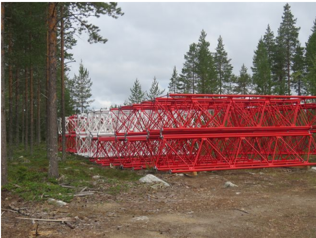
Kuva 21. Tuulimittaustornin runko, Itäjoenhaudankankaalla
