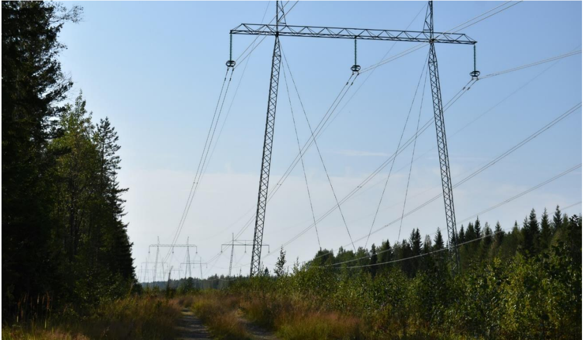
Kuva 12. Hankealueelle sijoittuu Fingridin 2 x 400 kV voimajohtokäytävä
